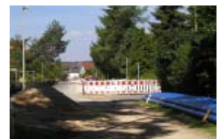
Rohrverlegung in der Ruhsteinstr.
