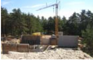
Baustelle in Kleinseebach
