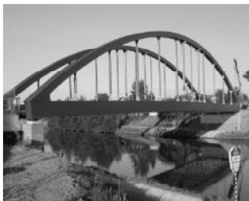
Geschafft: neues Brückenbauwerk überspannt Main-Donau-Kanal.
